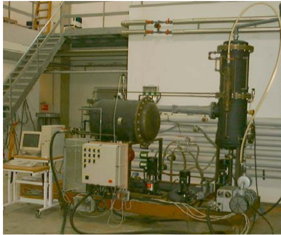
Figur 3-1: Ejektoranlæg opbygget i laboratoriet hos Teknologisk Institut
