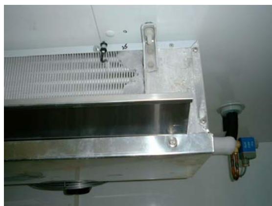
Figur 6: Til venstre ses luftkøleren i kølerummet, mens billedet til højre viser veksleren i frostrummet.
