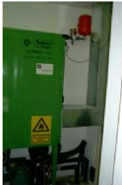
Figur 8: Brandsikret kasse med ventilationskanal til propananlæg
