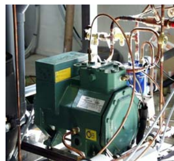
Figur 4: Semihermetisk prototypekompressor fra Bitzer til CO 2
