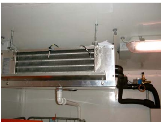
Figur 6: Til venstre ses luftkøleren i kølerummet, mens billedet til højre viser veksleren i frostrummet.
