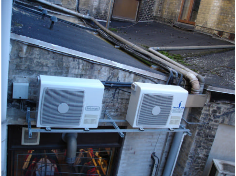
Figur 6.1: Udedele placeret på baggårdssiden af bygningen.
