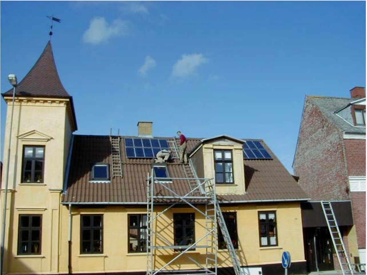
Figur B1.3: Montering af solceller på ejendom
