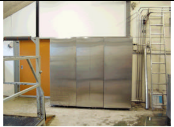
Figur Fejl! Ukendt argument for parameter.: Isbank.
