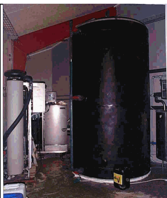
Figur Fejl! Ukendt argument for parameter.: Sjapistank og køleanlæg
