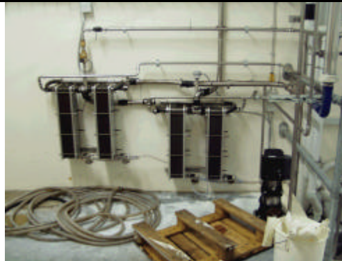
Figur Fejl! Ukendt argument for parameter.: Varmevexler til køling af mælk.
