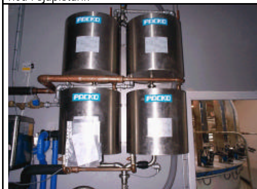
Figur Fejl! Ukendt argument for parameter.: Varmveksler til nedkøling af mælk
