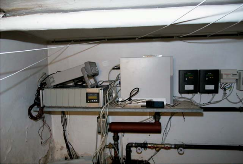
Billede 1.1.3: Måleudstyret blev placeret indvendigt på væg i kælderrum
