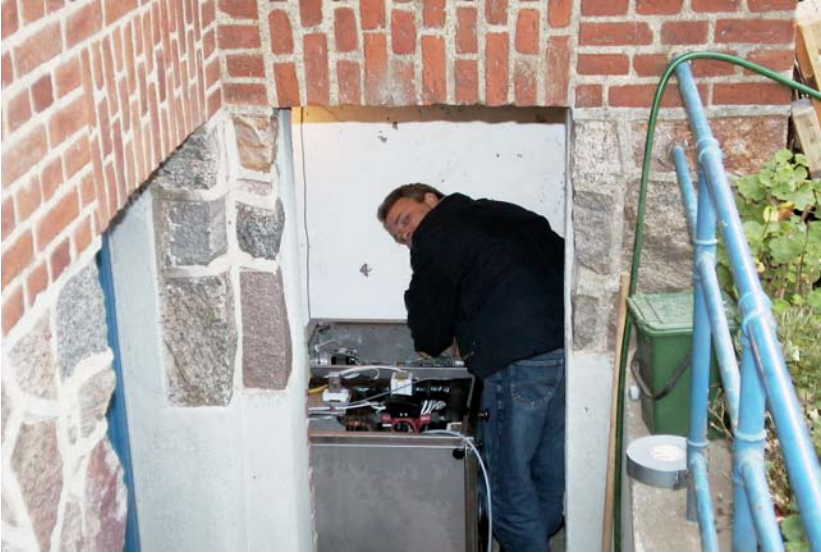
Billede 1.1.1: Varmepumpen er netop installeret og styringen kontrolleres af ekspert fra Lodam
