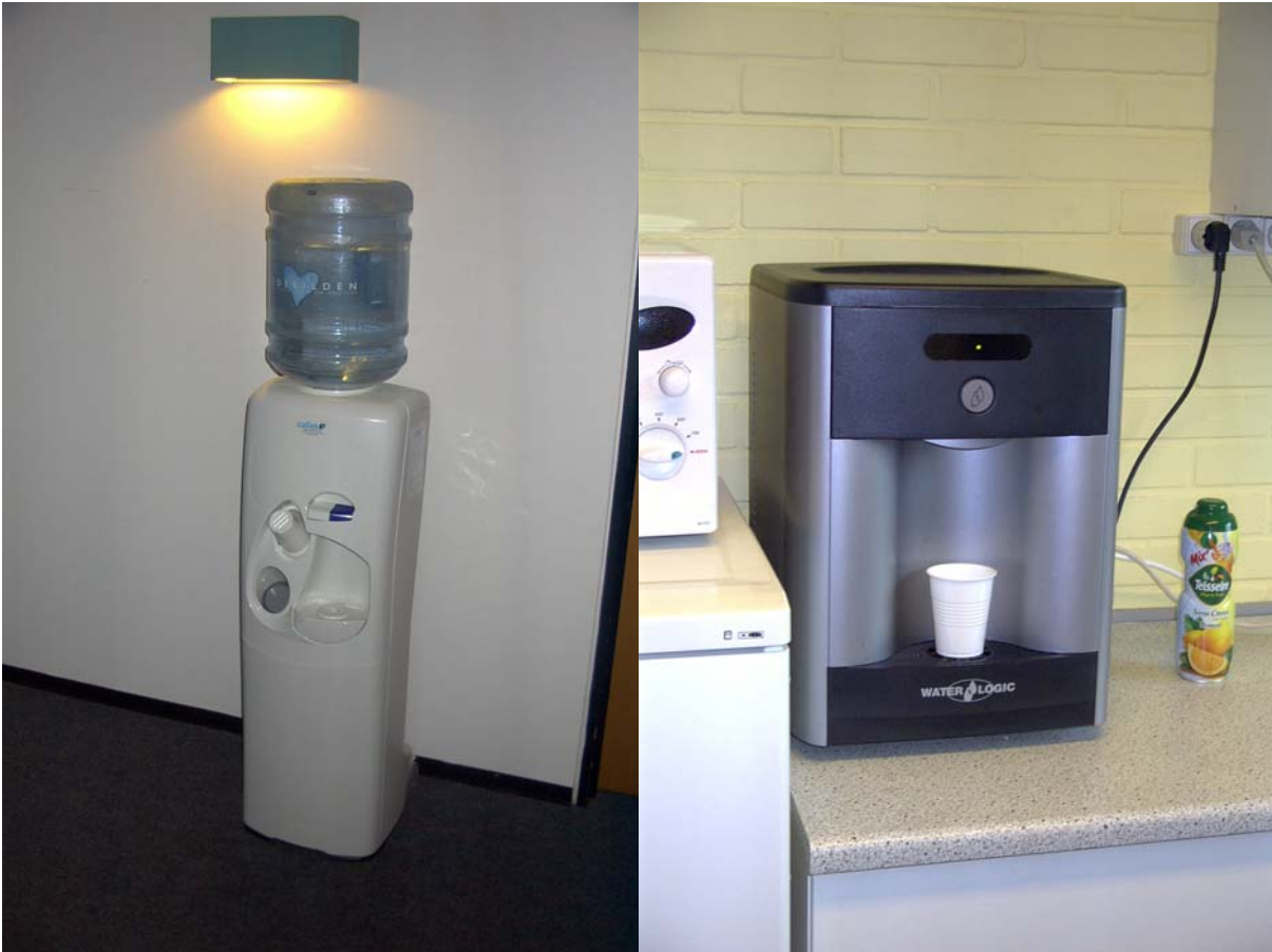
Fotos af hhv. kildevandskøler og postevandskøler. Begge er udstyret med kompressorkøleanlæg med R134a.
